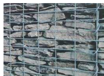
Gabionová zeď - tmavě šedý kámen(Břidlice, čedič)
