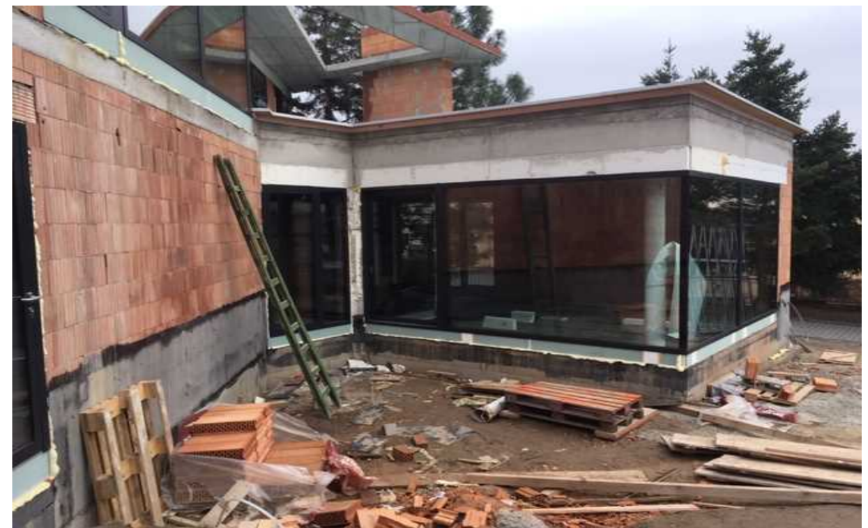
Obr. č. 6_Pohled na výšku terasy
